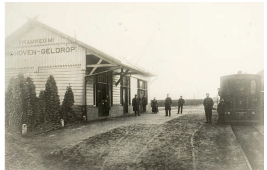
Loods op het Stationsplein van de Tramwegmaatschappij. Eindhoven-Geldrop. (collectie RHCE)
